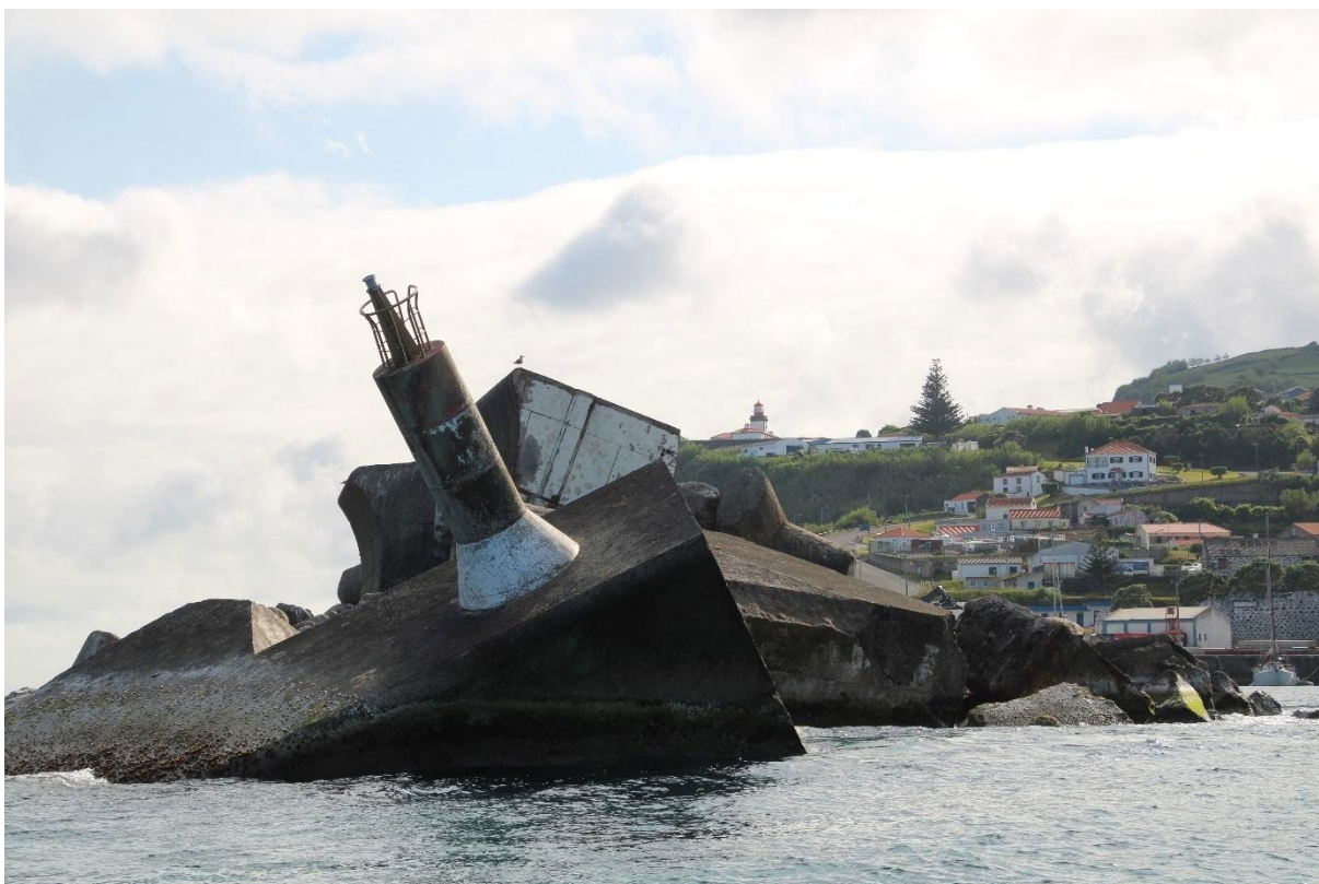
La digue de Flores
